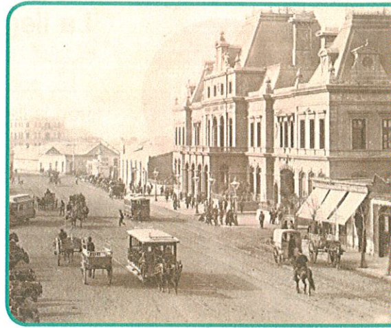
La estación ferroviaria Constitución, en la ciudad de Buenos Aires, a fines del siglo XIX.
